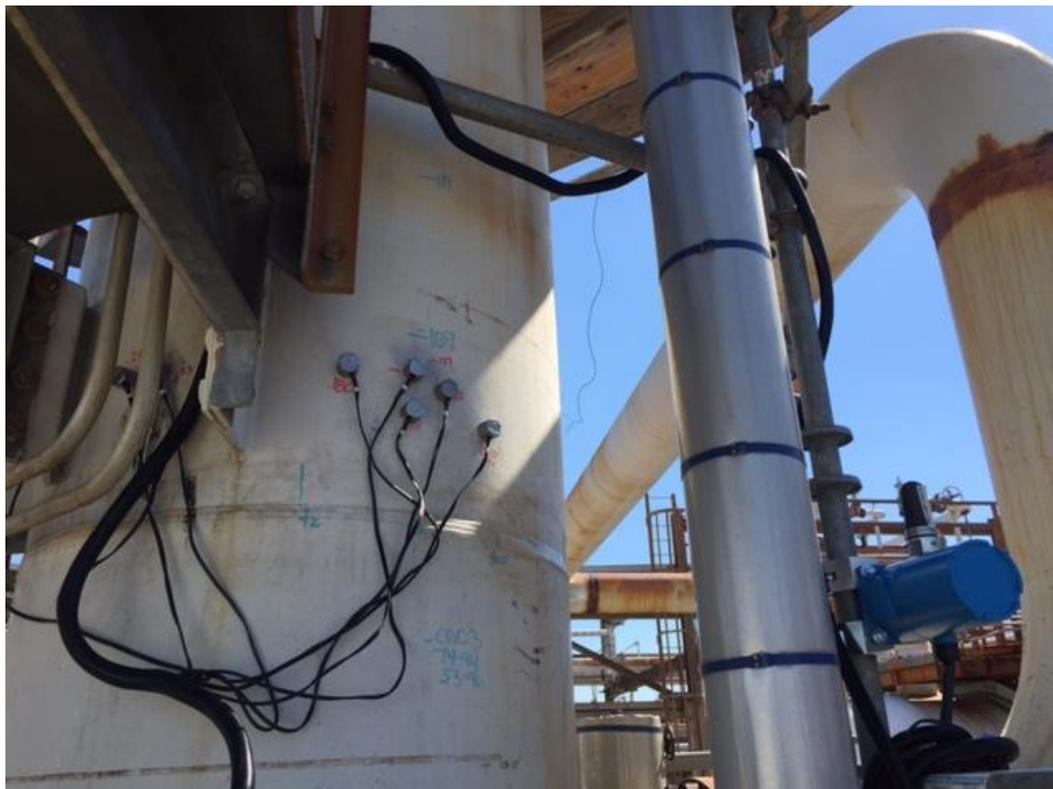
**Cellular smartPIMS:** Временно установлены двухэлементные датчики, контролирующие ямы для определения скорости коррозии, чтобы поддерживать установку в рабочем состоянии до капитального ремонта.
