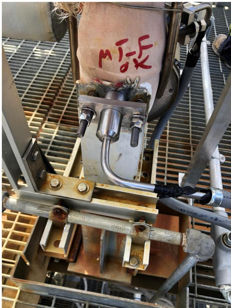
Одноэлементные сверхвысокотемпературные датчики устанавливаются с помощью приварных шпилек и кронштейнов. Зажимы нельзя использовать на переходниках, вблизи сварных швов или на трубах диаметром более 36 дюймов.
